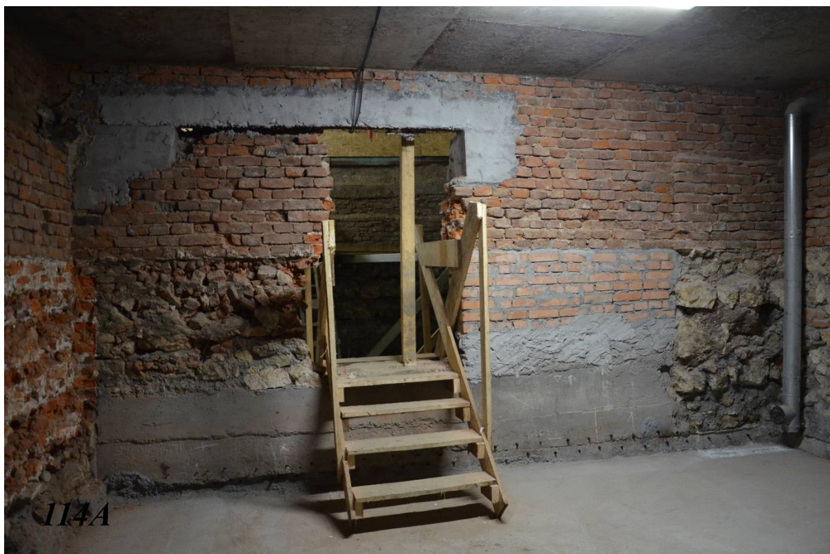
Część podziemna po wykonaniu podbić fundamentów
